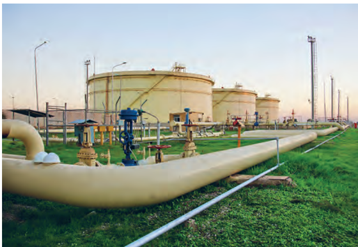
شکل ۲۱- نمایی از خطوط انتقال سوخت
